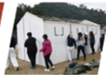
達成安全的棲身處 組合屋，模組化易組裝的建材，替代危樓成為住家或學校，多數建材重複再用於各地環境保護。
